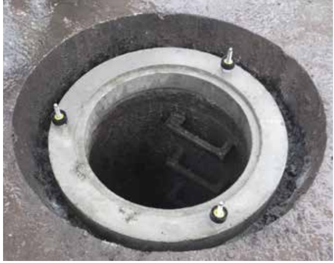
マンホール鉄蓋取替工事(円型取替工法での採用)
