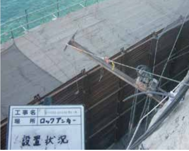
法面・斜面補強
