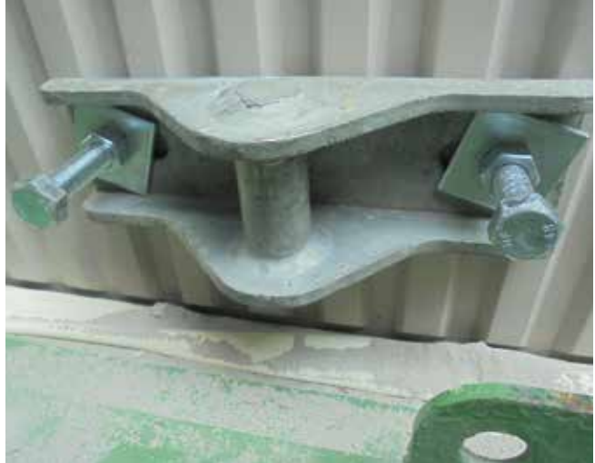
外壁養生台固定部
