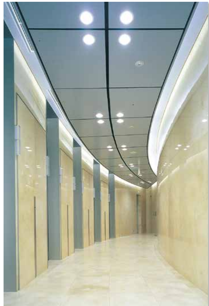
セコム本社ビル【東京都渋谷区】 機種 MD-NW、ドアコン
