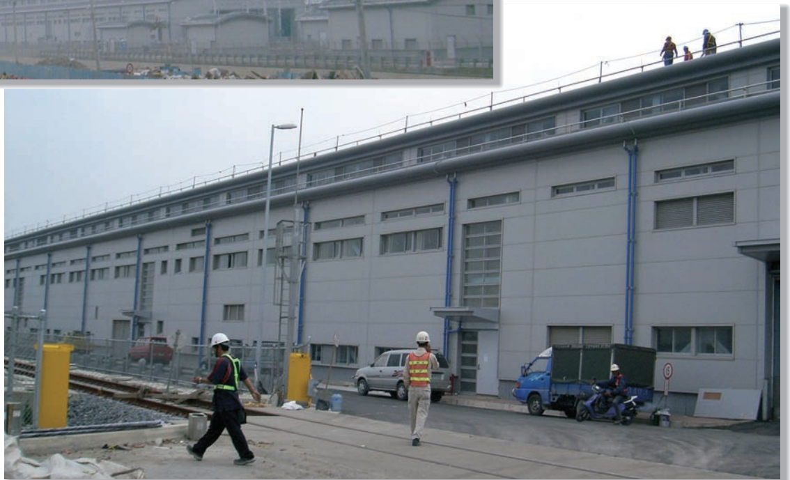
台湾高速鉄道中部(烏日)基地 車輛檢修棟 【台湾 台中県】 機種 MD-WEM
